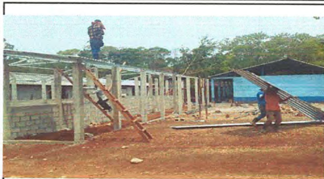
Foto 1: Comienzo de la instalación de techo de la cocina
